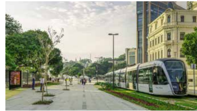
Luiz Paulo Conde Waterfront Promenade / Olympic Boulevard - Rio de Janeiro - B+ABR Backheuser e Riera Arquitetura
