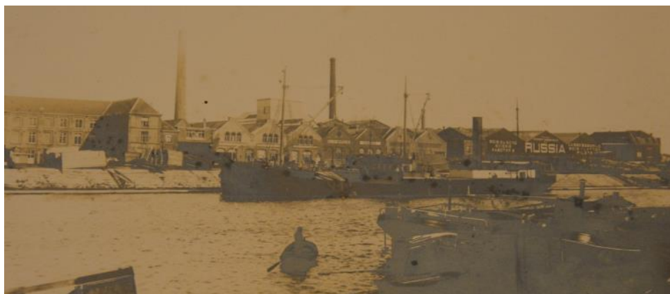
Fig: Foto uit eind 19 de eeuw met zicht op het gebouwenfront langs de Koopvaardijlaan vanaf de overzijde van het Handelsdok. Op de foto zijn de typerende 'trapgevels' van Triferto al te herkennen.
