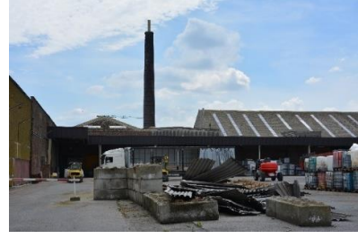
Foto: zicht op schoorsteen van site Triferto (8)
