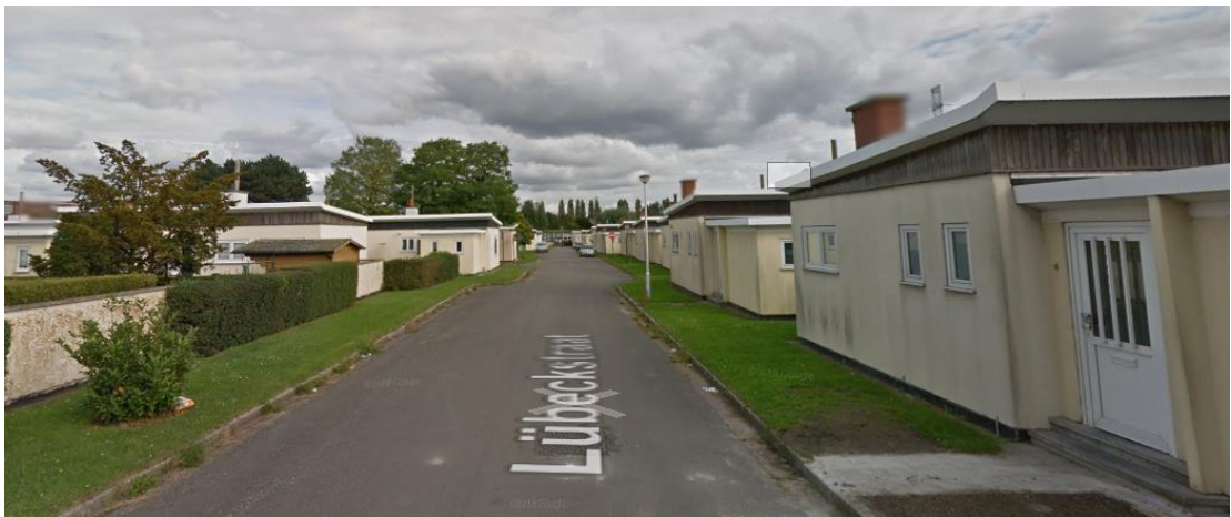
Zicht op de woningen van de Lübecksite (streetview, situatie 2009)
