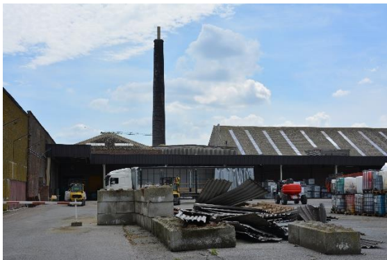
Foto : zicht op schoorsteen van site Triferto (8)
