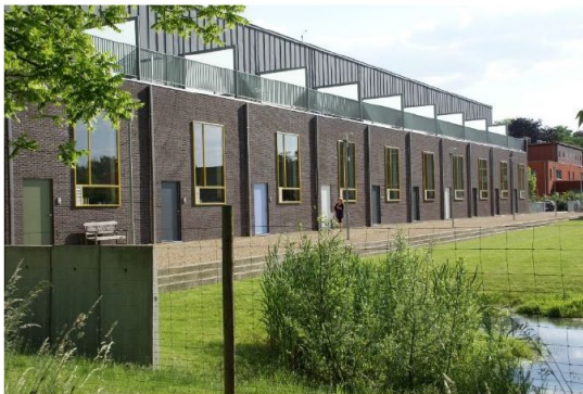
project Wonewei in Lovenjoel: compacte rijwoningen
